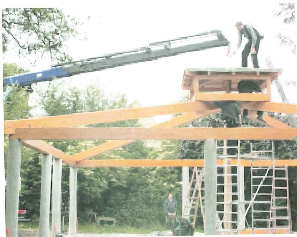
Grünes Klassenzimmer aus Holz und Beton: Hier wird dem Pavillon die Spitze aufgesetzt.
